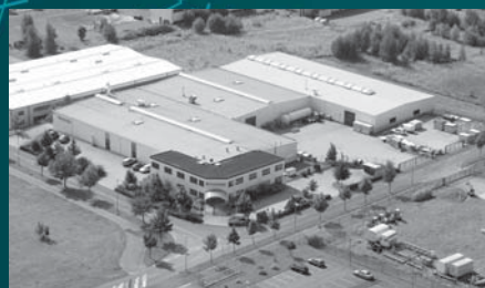
BOSECKER VERTEILERBAU SACHSEN GMBH, ZITTAU
